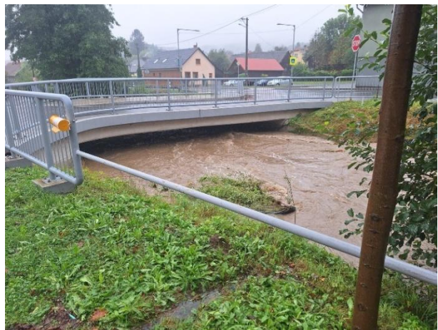
Obrázek 34: Koryto potoka Ratibořanka dimenzované na průtok Q_{1000} bylo ve dnech 15. – 17. září 2024 téměř plné (Zdroj: Archiv města Ratiboř, 2024)
