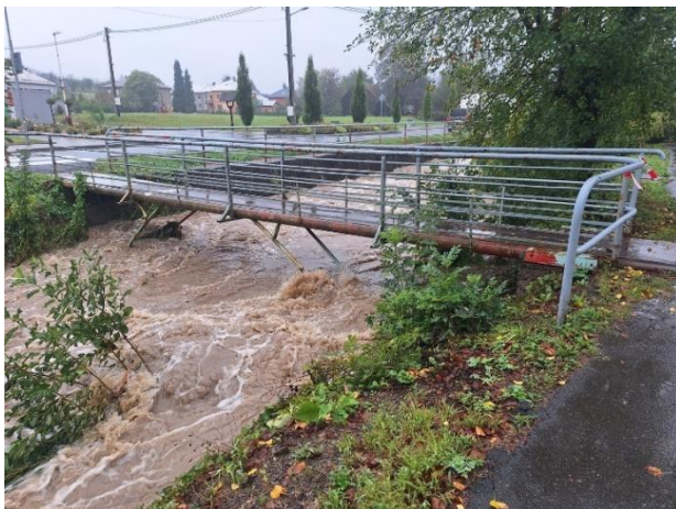
Obrázek 34: Koryto potoka Ratibořanka dimenzované na průtok Q_{1000} bylo ve dnech 15. – 17. září 2024 téměř plné (Zdroj: Archiv města Ratiboř, 2024)
