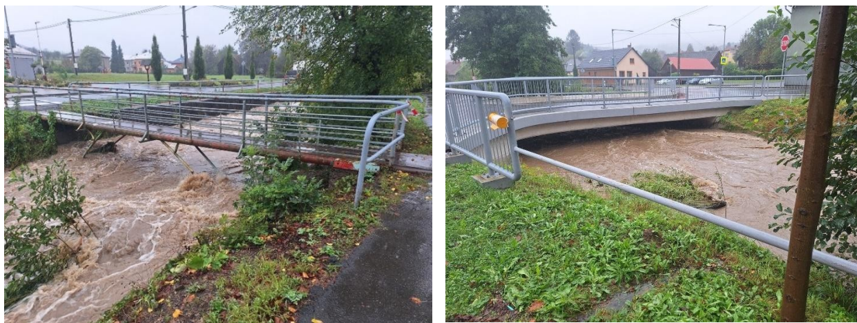
Obrázek 15: Koryto potoka Ratibořanka, dimenzované na průtok Q_{1000} , bylo ve dnech 15.-17. září 2024 téměř plné (Zdroj: Archiv města Ratiboř, 2024).
