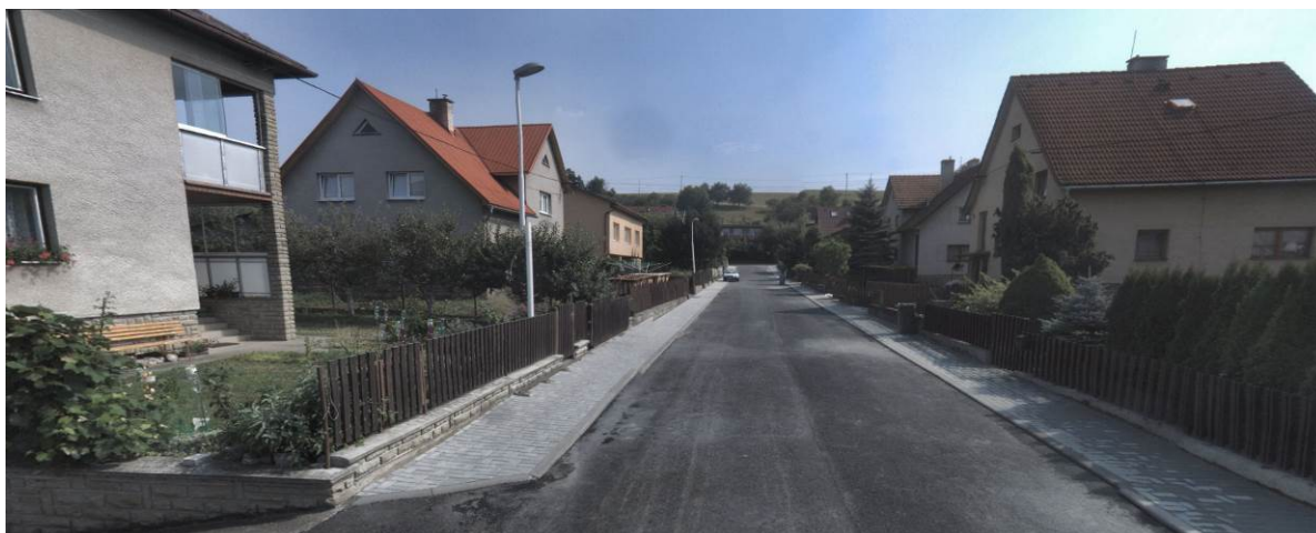
Novodobá obytná zástavba navazující na centrální část obce (pravoúhlá síť veřejných prostranství)
